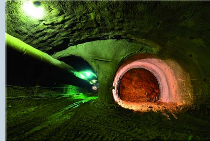
Istanbul Metro Line-Üsküdar-Ümraniye-Çekmeköy
